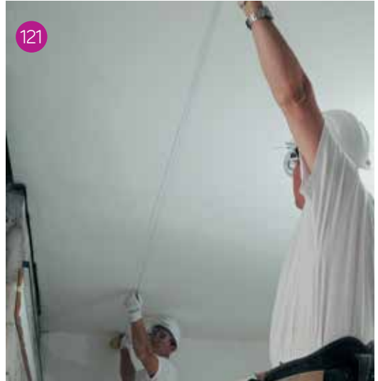
Tracciamento della posizione dei profili primari.
