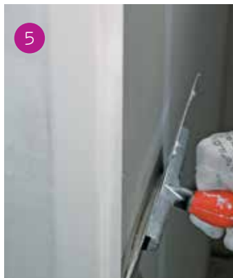
5 Rasatura dopo asciugatura della mano di serraggio, pressandola sullo spigolo.
