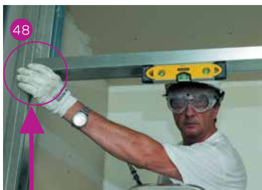
48 Fissaggio della guida ad architrave del vano porta. Nel dettaglio la configurazione a squadra della guida d'architrave.
