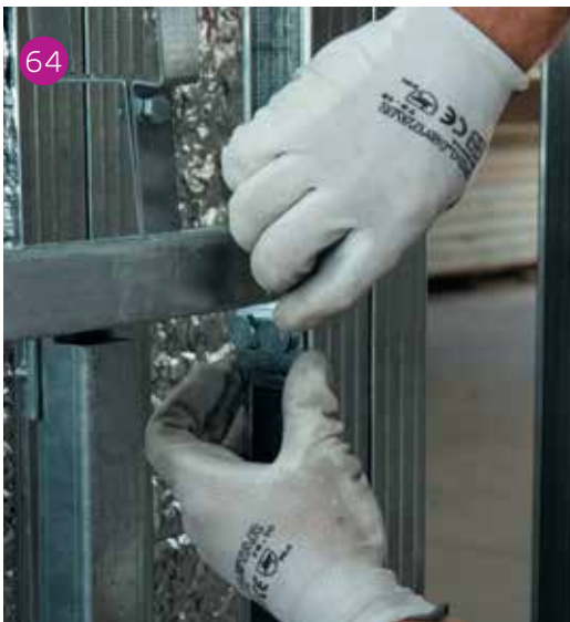
Applicazione delle piastre della traversa di controventatura del supporto e loro bloccaggio ai montanti.
