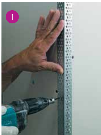
Fissaggio del paraspigolo tramite avvitatura.
