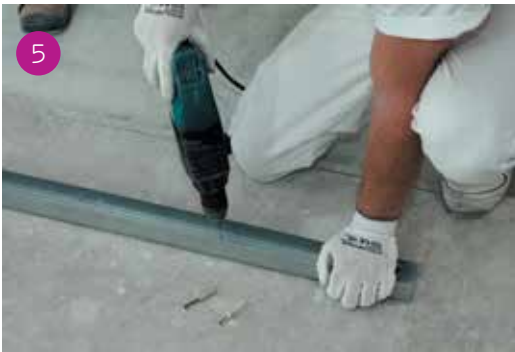
5 Fissaggio della guida tramite avvitatura con tasselli ogni 50 cm.
