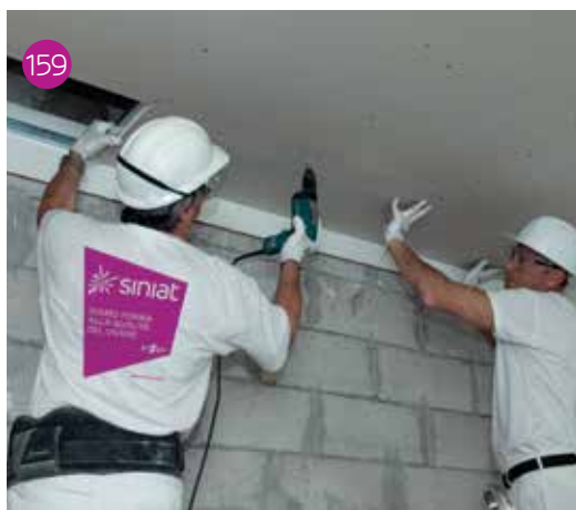
159 Installazione della lastra.
