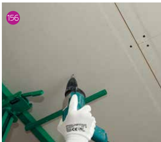
156 Dettaglio di avvitatura a ridosso dei bordi trasversali sfalsati.
