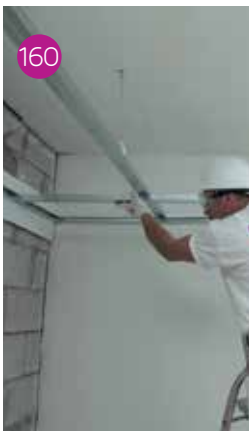
Avvitatura della barra filettata nel tassello a soffitto.
