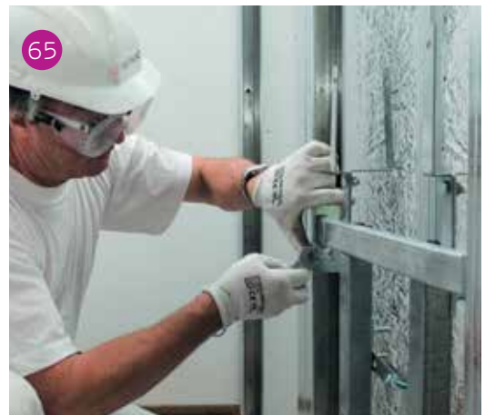
Applicazione delle piastre della traversa di controventatura del supporto e loro bloccaggio ai montanti.
