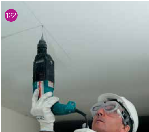
Esecuzione dei fori per i tasselli di aggancio dei pendini a interasse di progetto.
