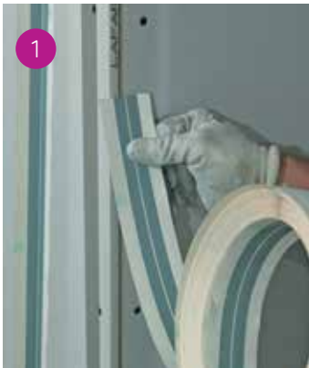
1 Misurazione del tratto di banda armata da applicare.
