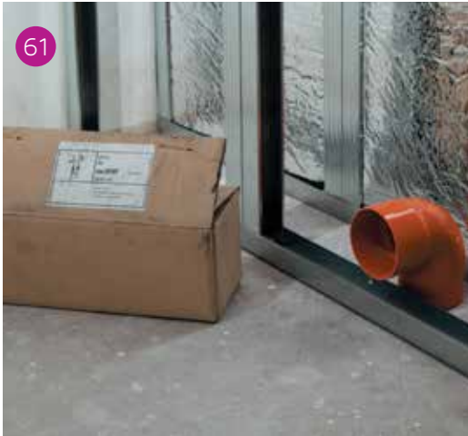
Gomito di scarico WC posizionato e la scatola del supporto.
