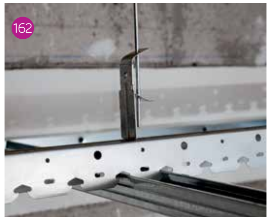
Impiego del "pendino clip" a molla con aggancio sulle asole della guida clip.
