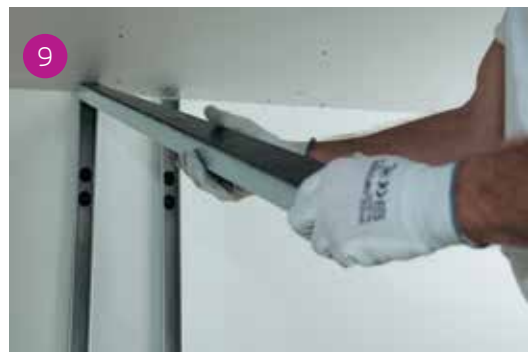
9 L'applicazione delle guide a soffitto avviene inserendole sulla testa dei montanti terminali.
