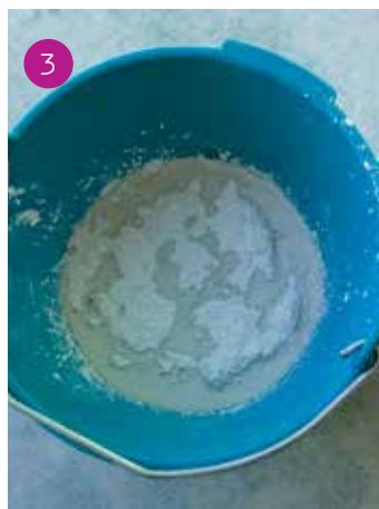
3 Lasciar riposare qualche minuto per consentire l'idratazione della polvere.
