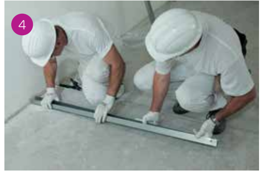
4 Applicazione della guida sulla traccia a pavimento.
