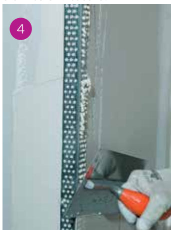
Riempimento dei due lati del paraspigolo.
