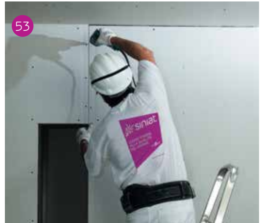
Applicazione e ritaglio "a bandiera" della 2° lastra con seghetto manuale e definizione del vano porta.
