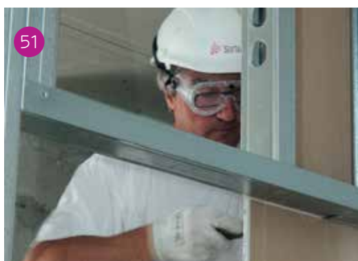
49 Misurazione per la definizione della larghezza della lastra "a bandiera" verso il sopraluce porta (fig. 49). Al fine di non creare linee di debolezza, in caso di sollecitazione dinamiche violente nell'uso delle porte, si deve evitare di posizionare giunti in corrispondenza degli stipiti: il montante intermedio inserito nel sopraluce serve al fissaggio del ritaglio "a bandiera" della lastra.
