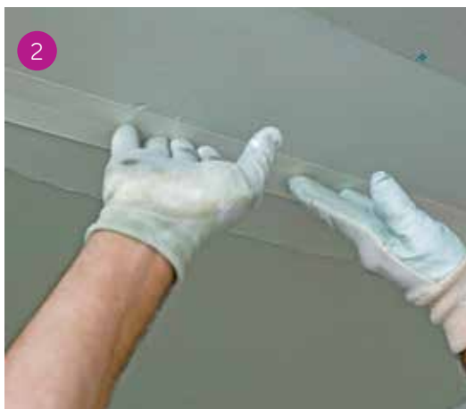
2 Applicazione della banda.
