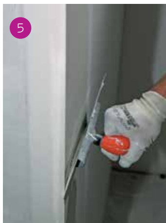
Rasatura dopo asciugatura della mano di riempimento.
