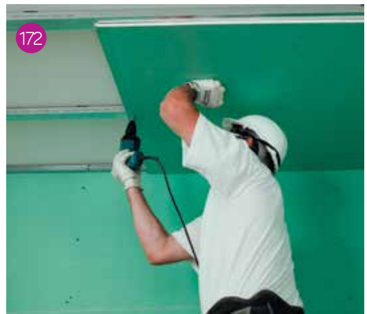
172 Applicazione della prima lastra Pregydro procedendo a chiudere con i metodi applicativi indicati da pag. 68 a pag. 70.
