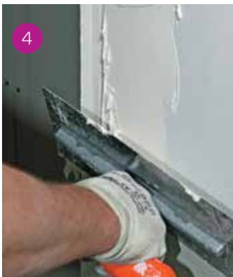
4 Serraggio della banda con l'americana.
