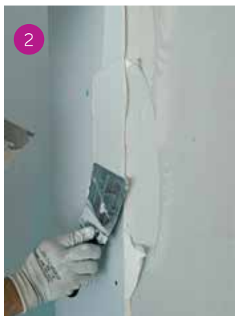
Imburraggio dello spigolo.
