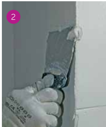
2 Imburraggio dello spigolo con lo stucco.
