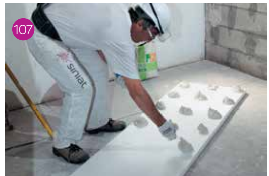
Applicazione di plotte di collante su pannello di espanso.
