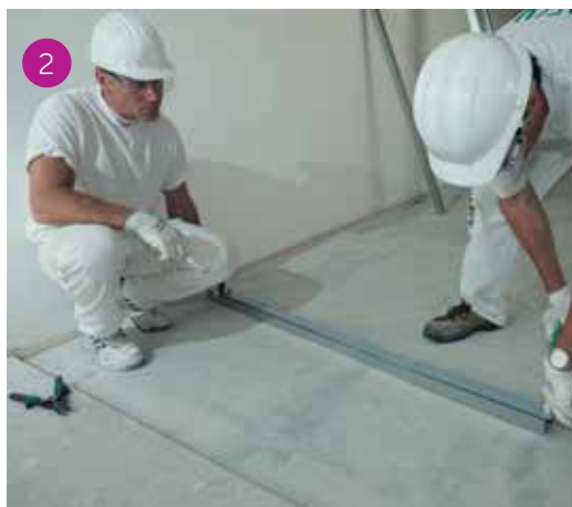
Applicazione della banda resiliente adesiva sul dorso della guida a pavimento.
