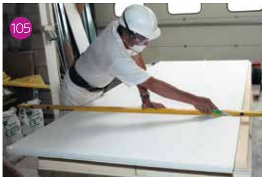
Taglio trasversale del pannello isolante nel caso di tensioni d'imbarco. Può succedere, a volte, con spessori di isolante superiori a 3 cm.
