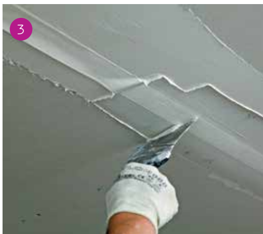
3 Serraggio della banda con rimozione delle sbavature.
