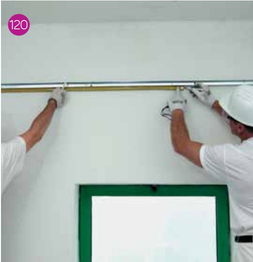
Tracciamento dei punti d'interesse dei profili primari.
