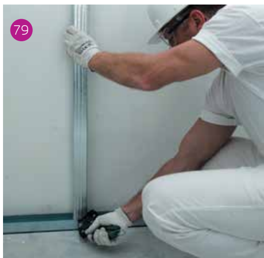
Fissaggio dei montanti tramite punzonamento.
