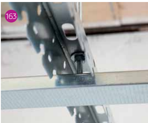
Dettaglio d'incastro tra profilo primario e secondario.
