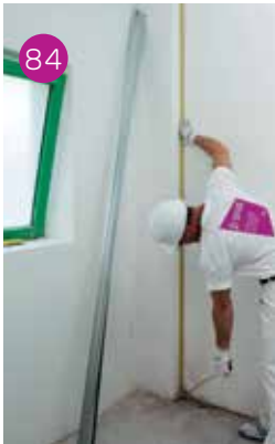
84 Verifiche dimensionali prima dell'incollaggio dei pannelli di estruso.
