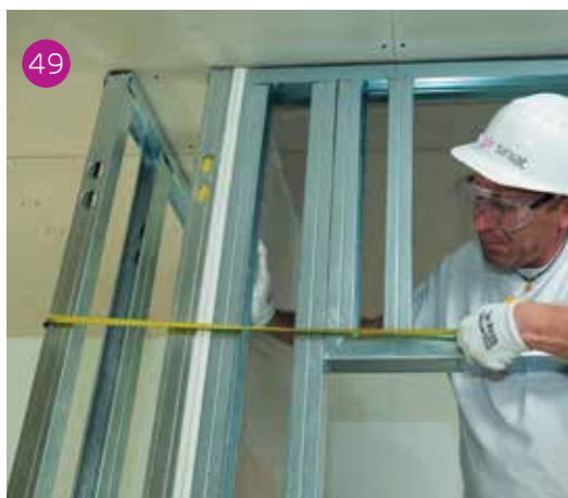
49 Misurazione per la definizione della larghezza della lastra "a bandiera" verso il sopraluce porta (fig. 49). Al fine di non creare linee di debolezza, in caso di sollecitazione dinamiche violente nell'uso delle porte, si deve evitare di posizionare giunti in corrispondenza degli stipiti: il montante intermedio inserito nel sopraluce serve al fissaggio del ritaglio "a bandiera" della lastra.
