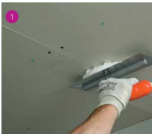
1 Imburraggio del giunto trasversale Synia.
