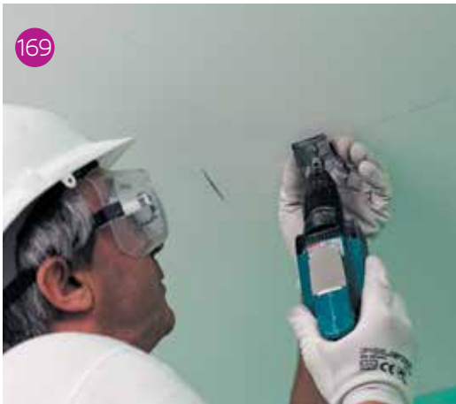
169 Fissaggio dell'attacco. La vite centrale ne permette la registrazione a livello.
