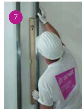
6 La parete può essere tracciata con il laser o con il pratico sistema utilizzato: si posizionano i montanti a ridosso della parete di partenza e si fissano verticalmente con il controllo della livella magnetica.
