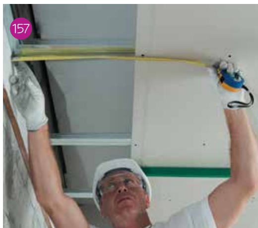
157 Misurazione della larghezza della banda di lastra a chiusura del controsoffitto. Si devono considerare circa 2 mm in meno per evitare tensioni superficiali del controsoffitto legate alle dilatazioni termiche dei profili.
