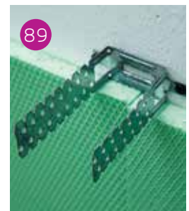
88 La staffa regolabile viene messa in posizione con la richiusura dell'ala dopo il fissaggio a muro (fig. 88 - 89).
