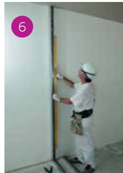
6 La parete può essere tracciata con il laser o con il pratico sistema utilizzato: si posizionano i montanti a ridosso della parete di partenza e si fissano verticalmente con il controllo della livella magnetica.
