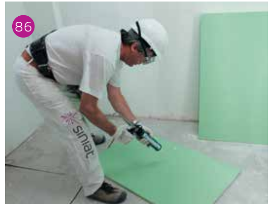
86 Stesura del collante sul pannello di estruso.
