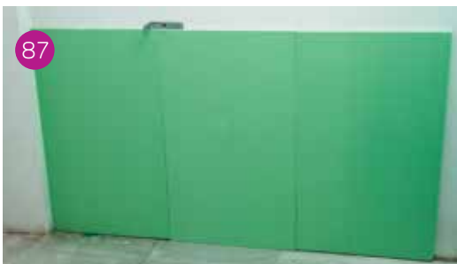
87 Incollaggio dei pannelli isolanti fino alla quota delle staffe regolabili o degli attacchi distanziatori (fig. 87).
