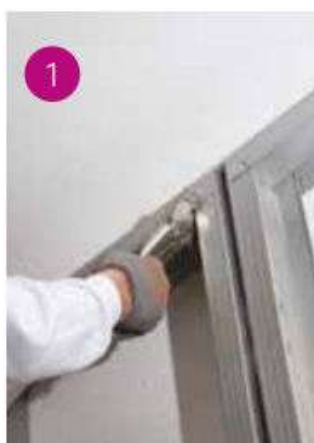
Raddoppio dell'orditura metallica in corrispondenza del giunto
