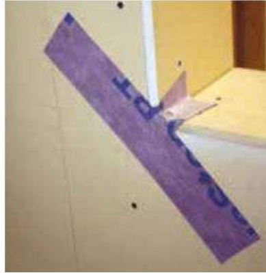
Posa della membrana impermeabilizzante nei 4 angoli dell'apertura
