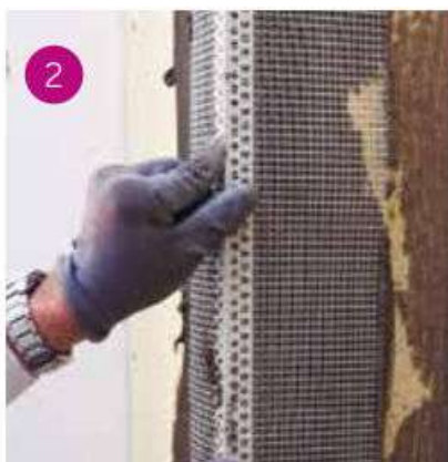
Posa del paraspigolo / gocciolatoio in PVC
