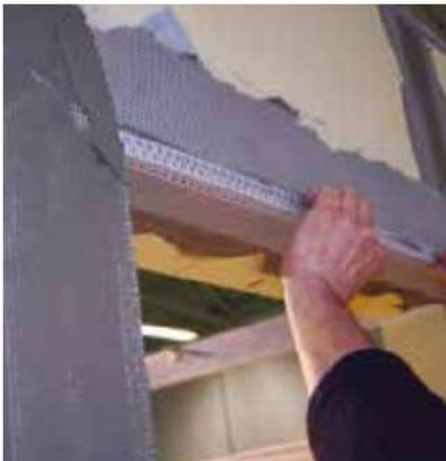
Posa di parasigolo in PVC sui lati verticali e di gocciolatoio in PVC sull'architrave superiore, avendo cura di sagomare gli estremi a 45°
