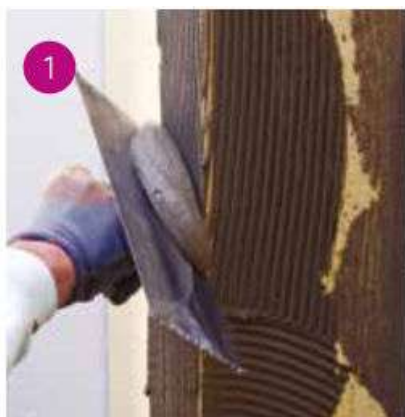
Applicazione di Adesivo&Rasante XT in corrispondenza degli spigoli
