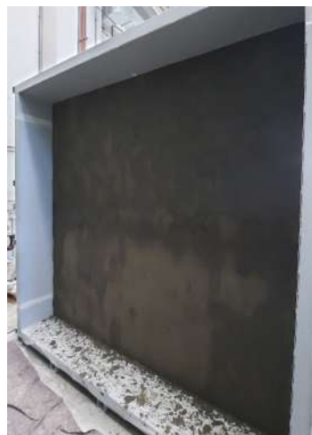
Seconda mano di rasatura con MAPEFINISH (sp. 2 mm)
