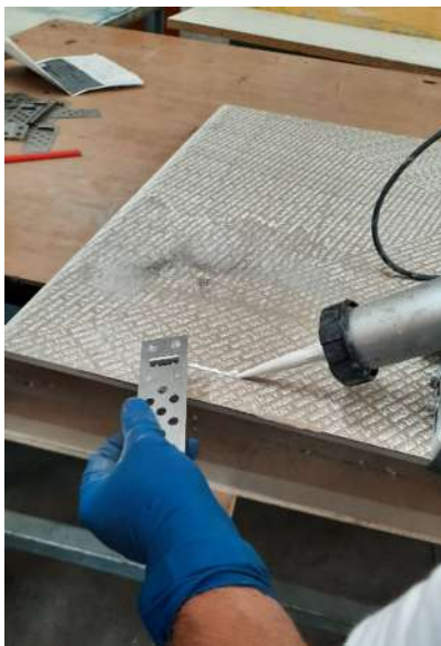
Posizionamento ganci RAI-FIX sul retro delle piastrelle
