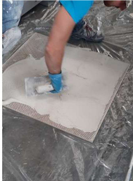
Applicazione di ULTRALITE S2 FLEX sulla piastrella
