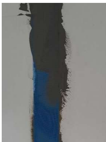
Stesura di strisce di rete MAPENET 150 di larghezza 20 cm
