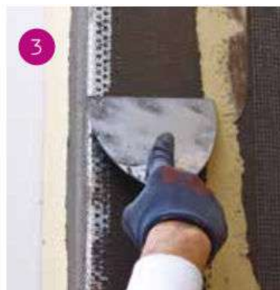
Completamento con ulteriore strato di Adesivo&Rasante XT
