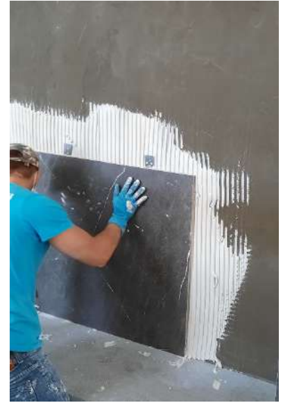
Incollaggio con tecnica della doppia spalmatura
