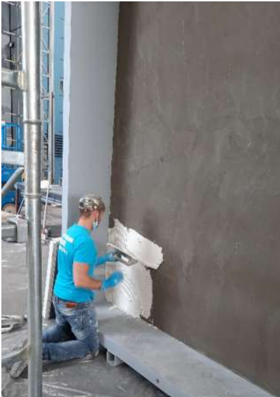
Applicazione di ULTRALITE S2 FLEX sul supporto
