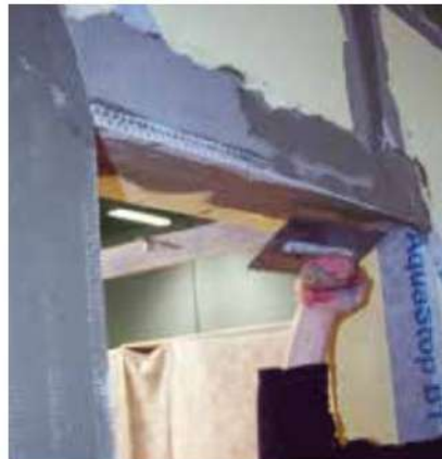
Posa di parasigolo in PVC sui lati verticali e di gocciolatoio in PVC sull'architrave superiore, avendo cura di sagomare gli estremi a 45°
