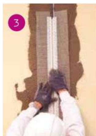
Posa del giunto di dilatazione in PVC e completamento con ulteriore strato di Adesivo&Rasante XT
