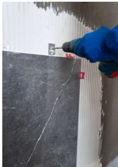
Incollaggio della piastrella e realizzazione dei fori nel supporto
