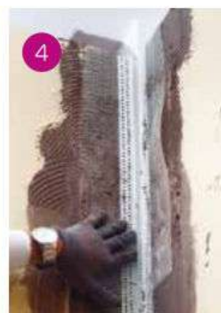
Posa del giunto di dilatazione in PVC e completamento con ulteriore strato di Adesivo&Rasante XT
