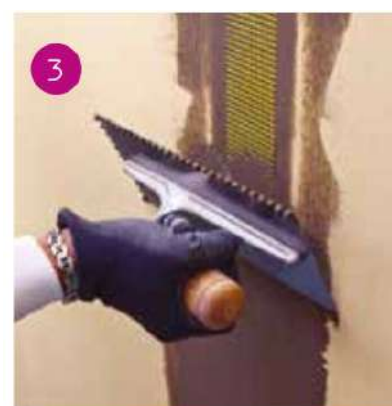
Completamento del giunto con una nuova mano di Adesivo&Rasante XT
