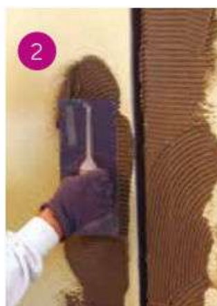
Posa delle lastre mantenendo uno spazio di 1-2 cm tra le stesse e applicazione di Adesivo&Rasante XT
