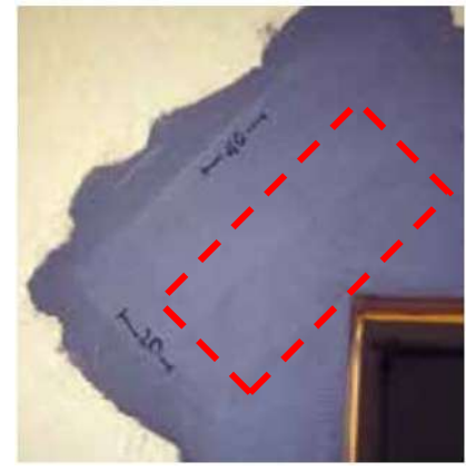
Rinforzo aggiuntivo con strisce di Rete XT di dimensioni 40x20 cm posate a 45° sugli angoli, ponendo attenzione ad evitare eccessivi inspessimenti e possibili inestetismi
