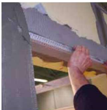
Posa di paraspigolo in PVC sui lati verticali e di gocciolatoio in PVC sull'architrave superiore, avendo cura di sagomare gli estremi a 45°
