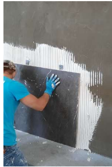
Incollaggio con tecnica della doppia spalmatura
