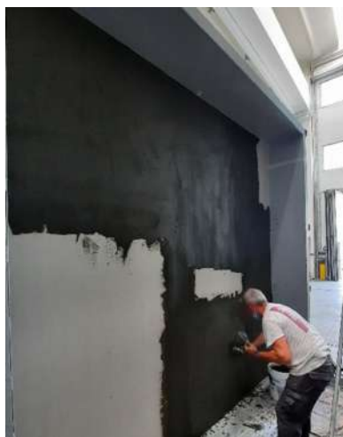
Prima mano di rasatura con MAPEFINISH (sp. 2 mm)
