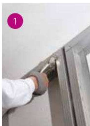
Raddoppio dell'orditura metallica in corrispondenza del giunto
