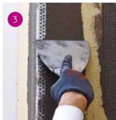
Completamento con ulteriore strato di Adesivo&Rasante XT
