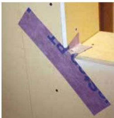
Posa della membrana impermeabilizzante nei 4 angoli dell'apertura
