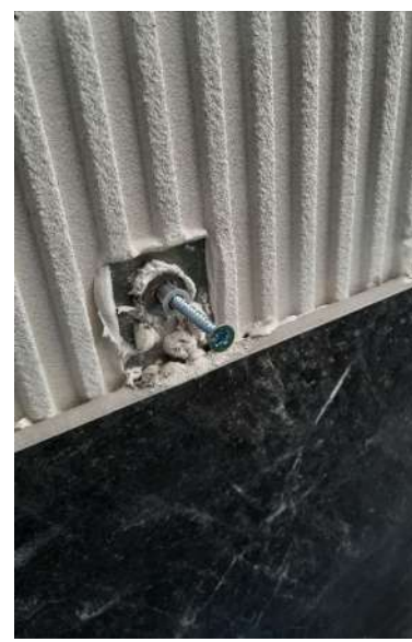
Fissaggio con tasselli / viti
