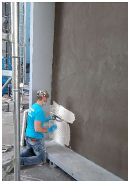
Applicazione di ULTRALITE S2 FLEX sul supporto
