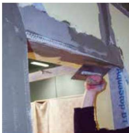
Posa di paraspigolo in PVC sui lati verticali e di gocciolatoio in PVC sull'architrave superiore, avendo cura di sagomare gli estremi a 45°
