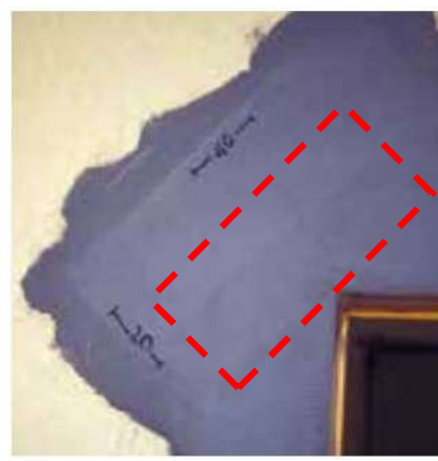
Rinforzo aggiuntivo con strisce di Rete XT di dimensioni 40x20 cm posate a 45° sugli angoli, ponendo attenzione ad evitare eccessivi inspessimenti e possibili inestetismi
