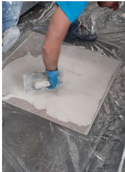
Applicazione di ULTRALITE S2 FLEX sulla piastrella
