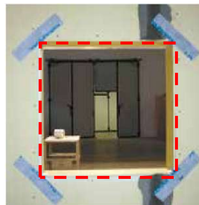
Posa della membrana impermeabilizzante sull'intero perimetro del vano di apertura, piegandola opportunamente sugli spigoli
