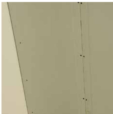
Avvitatura delle lastre solo sui montanti
