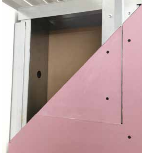
Fusibile e giunto telescopico
