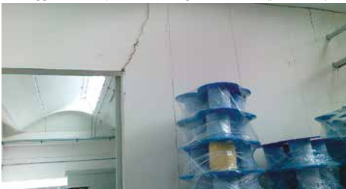
Danneggiamento di pareti in cartongesso standard (prive di dispositivi di scorrimento) a seguito di un terremoto
