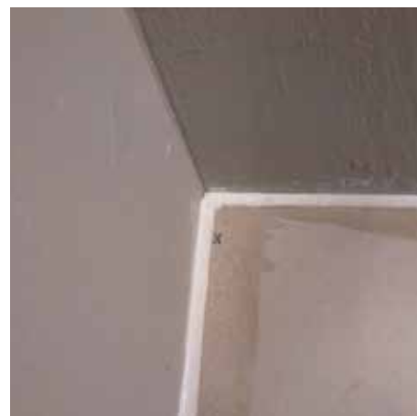
Sigillatura dei giunti perimetrali con mastice acrilico verniciabile
