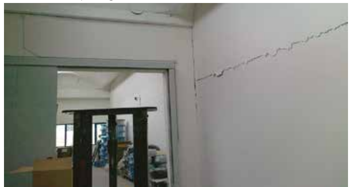
Danneggiamento di pareti in cartongesso standard (prive di dispositivi di scorrimento) a seguito di un terremoto
