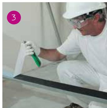
3 Per massimizzare le prestazioni acustiche del sistema, applicare il nastro monoadesivo in polietilene sul dorso delle guide e dei profili perimetrali.
