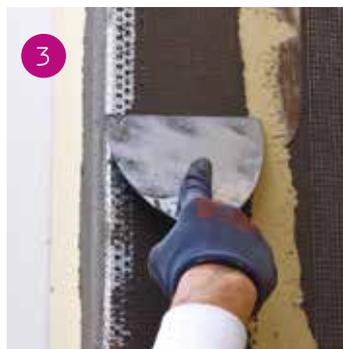
Terza Fase: ultimare con un ulteriore strato di rasante.
