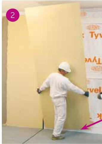
Per evitare il fenomeno di risalita di umidità dalla base della parete, posizionare le lastre AquaBoard ad una distanza di almeno 1 cm dalla pavimentazione esterna, proteggendole tramite il profilo di partenza in alluminio AquaBoard.
