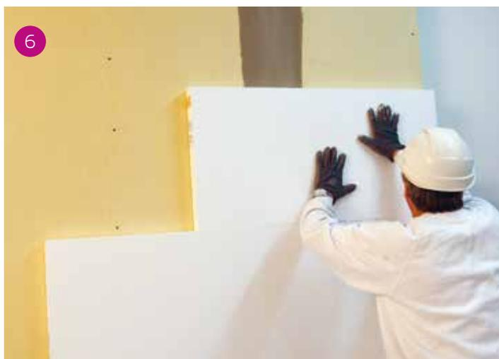
Tutti i pannelli termocoibenti devono essere ben pressati sul supporto in modo da distribuire uniformemente l'Adesivo&Rasante AquaBoard garantendo così una totale adesione. La posa e l'eventuale registrazione dei pannelli devono essere eseguite sempre con l'Adesivo&Rasante AquaBoard fresco e appena steso: eventuali movimenti o registrazioni dei pannelli ad inizio presa possono determinare un'adesione precaria fino al distacco.
