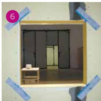
6 Procedere al posizionamento della membrana impermeabilizzante sull'intero perimetro del vano di apertura, piegandola opportunamente sugli spigoli.
