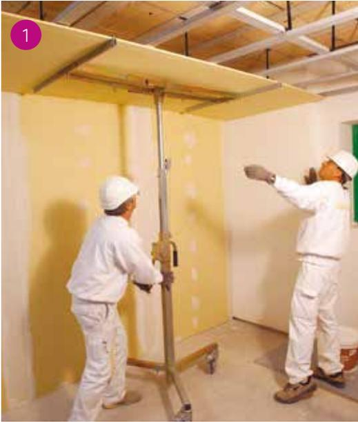
Le lastre AquaBoard devono essere fissate esclusivamente su struttura metallica PregyMetalAquaBoard. Posare le lastre AquaBoard trasversalmente all'orditura metallica, similmente alle applicazioni a secco in cartongesso.
