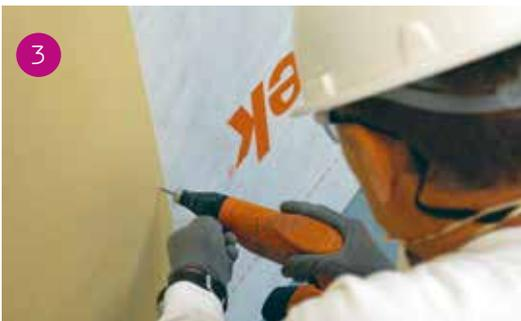
Fissare la lastra AquaBoard ai profili metallici PregyMetalAquaBoard con viti autofilettanti AquaBoard ad interasse massimo di 300 mm (un' interasse minore potrebbe essere necessario in funzione della verifica statica).
