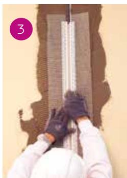
Annegare il giunto di dilatazione lineare o angolare nello strato di Adesivo&Rasante AquaBoard ed ultimare con un ulteriore strato di rasante.
