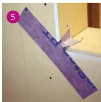
Per il trattamento degli spigoli provvedere al taglio della membrana impermeabile "a coda di rondine" nelle dimensioni di 35, 2+2, 4+4 cm e procedere alla posa nei 4 angoli come indicato in figura.
