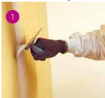
Riempimento del giunto con Stucco AquaBoard e stuccatura della testa delle viti.
