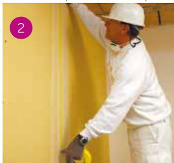
Applicare la banda in rete AquaBoard centrandola sull'asse del giunto.
