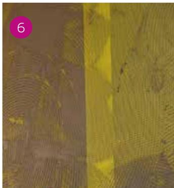
Nella stesura della rete sull'intera superficie, si raccomanda di sormontarla lateralmente per almeno 10 cm allo strato precedente.
