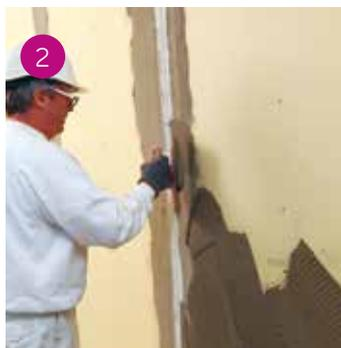
2 Dopo la completa asciugatura del giunto, si può procedere con la rasatura della superficie delle lastre AquaBoard: applicare una prima mano di Adesivo&Rasante AquaBoard nello spessore di circa 3 mm con una spatola dentata in acciaio.
