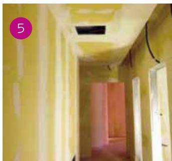
Lasciare asciugare per 24/48 ore in funzione delle condizioni atmosferiche e procedere con l'ultima mano di finitura per rendere planare il giunto.
