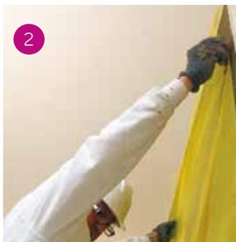
Dopo la stesura dell'Adesivo&Rasante AquaBoard si prosegue posando la rete AquaBoard (rotolo da 1\*50 m), avendo cura di farla aderire allo strato di rasante, senza annegarla. Porre particolare attenzione e cura nell'applicazione della rete per evitare la formazione di pieghe e/o bolle.
