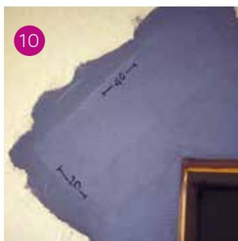
10 Sugli angoli delle aperture (porte e finestre) è consigliabile prevedere un rinforzo aggiuntivo, introducendo delle strisce di nastro in rete AquaBoard di 160 gr di dimensioni di circa 40x20 cm, posate a 45° sugli spigoli per impedire l'eventuale formazione di fessurazioni.
