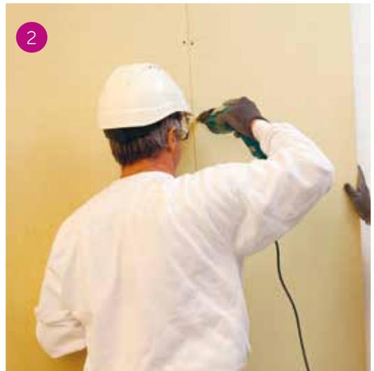
2 Fissare la lastra AquaBoard ai profili metallici PregyMetalAquaBoard con viti autofilettanti AquaBoard ad interasse massimo di 300 mm (un interasse minore potrebbe essere necessario in funzione della verifica statica). Poiché le lastre hanno un'elevata stabilità dimensionale, vengono installate accostate senza lasciare spazi tra i giunti e in ogni caso ad distanza massima di 1-2 mm.
