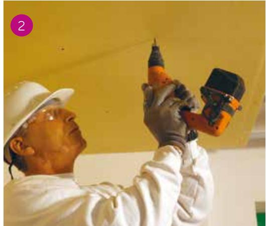
Fissare la lastra AquaBoard ai profili metallici PregyMetalAquaBoard con viti autofilettanti AquaBoard ad interasse massimo di 300 mm (un interasse minore potrebbe essere necessario in funzione della verifica statica). Si raccomanda di prestare attenzione alla corretta avvitaratura.
