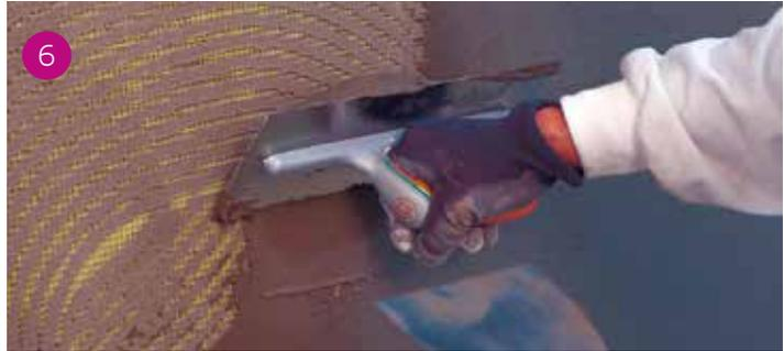
Proseguire con la stesura della seconda mano di Adesivo&Rasante AquaBoard nello spessore di almeno ulteriori 2 mm per regolarizzare la superficie. Lo spessore totale della rasatura deve essere pari ad almeno 5 mm. La rete AquaBoard risulterà pertanto posizionata nel terzo più esterno di Adesivo&Rasante AquaBoard.
