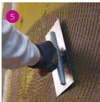
4 Dopo la stesura dell'Adesivo&Rasante AquaBoard si prosegue posando la rete AquaBoard (rotolo da 1\*50 m), avendo cura di farla aderire allo strato di rasante, senza annegarla. Porre particolare attenzione e cura nell'applicazione della rete per evitare la formazione di pieghe e/o bolle.
