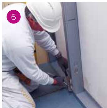
6 Fissare i montanti alle guide superiori e inferiori mediante punzonatura.
