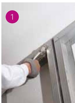
Per una corretta esecuzione, prevede l'interruzione dell'orditura metallica ogni 15 m e in corrispondenza dei giunti strutturali.
