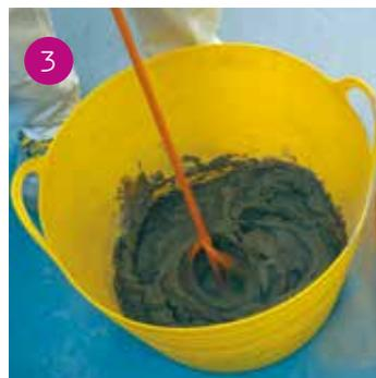
Procedere all'impasto dell'Adesivo&Rasante AquaBoard manualmente o con miscelatore meccanico a basso numero di giri fino ad ottenere un impasto omogeneo e privo di grumi e bolle d'aria. Impiegare circa 7 litri di acqua ogni 25 kg di rasante in polvere.
