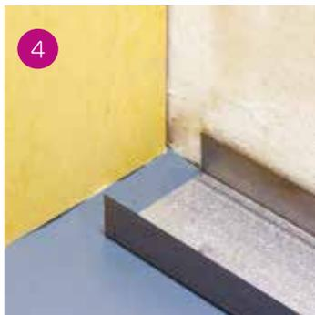
4 Fissare le guide a pavimento e soffitto con tasselli idonei alla tipologia di supporto presente ad interasse massimo 500 mm.
