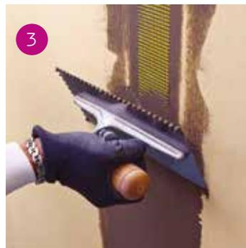
Prima fase: riempimento tramite Adesivo&Rasante AquaBoard.
