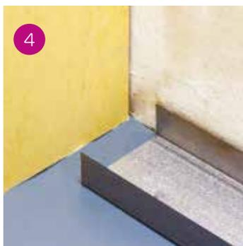
4 Fissare le guide a pavimento e soffitto con tasselli idonei alla tipologia di supporto presente.
