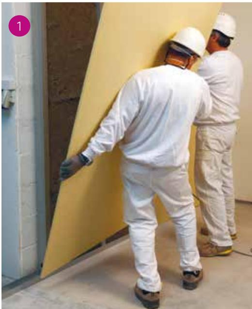
1 La posa delle lastre AquaBoard viene effettuata in verticale. Per evitare il fenomeno di risalita di umidità dalla base della parete, posizionare le lastre AquaBoard ad una distanza di almeno 1 cm dalla pavimentazione.
