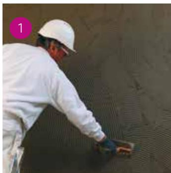
Dopo la completa installazione dell'isolante, si può procedere con la rasatura della superficie; applicare una prima mano di Adesivo&Rasante AquaBoard nello spessore di circa 3 mm con una spatola dentata in acciaio.
