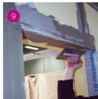
7 Posizionare il Paraspigolo in PVC e rete lungo i tratti verticali dell'apertura e il paraspigolo in pvc con gocciolatoio sul tratto orizzontale superiore, avendo cura di sagomare gli estremi a 45°.
