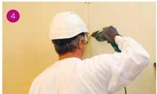
Poiché le lastre hanno un'elevata stabilità dimensionale, vengono installate accostate senza lasciare spazi tra i giunti e in ogni caso ad distanza massima di 1-2 mm.
