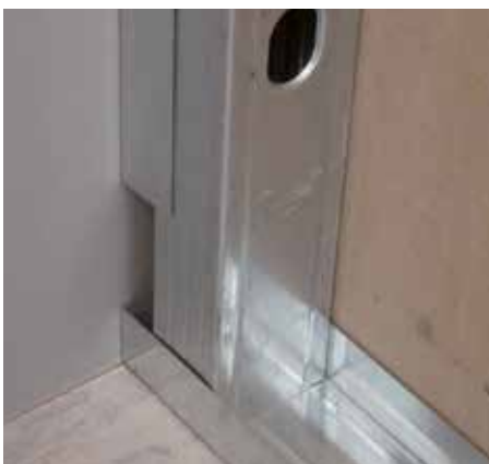
Giunto telescopico con montante libero di scorrere nella guida laterale
