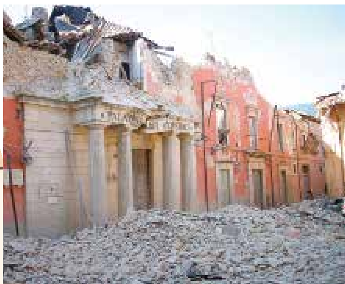
Danni causati da un terremoto
