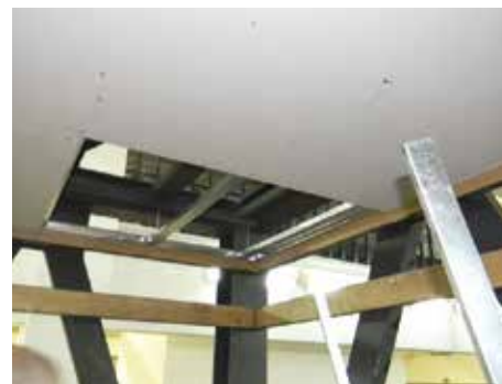
Installazione nel telaio di prova
