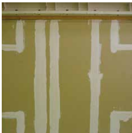
Test nel piano - Parete prima della prova
