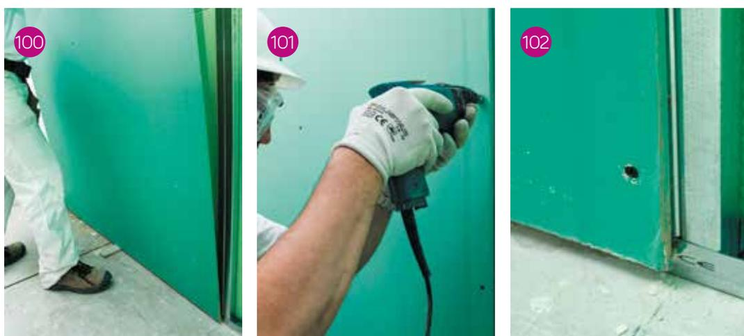
Applicazione della lastra (Pregydro per ambienti umidi in questo caso) tramite avvitatura (fig. 100 - 101).
