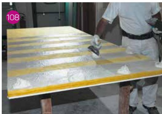
Nel caso di pannelli in fibra minerale, il posizionamento delle plotte, richiede la preventiva stesura di fasce di collante liquido per irrigidire le fibre in corrispondenza della loro applicazione.
