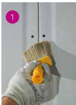
I giunti vanno ripuliti da polvere depositata durante le lavorazioni.
