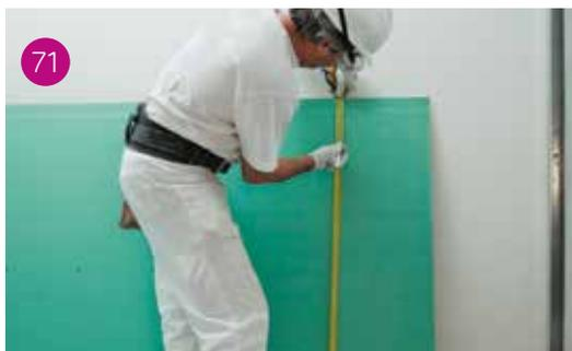
Misurazione del posizionamento dei perni di supporto e del gomito di scarico per l'esecuzione dei fori corrispondenti sulla lastra idrofuga Pregydro.
