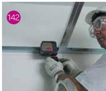
Controllo di planarità dell'orditura metallica con livella magnetica o luce laser per procedere ad eventuali assestamenti dei pendini dei profili primari prima dell'applicazione delle lastre (fig. 141 - 142).
