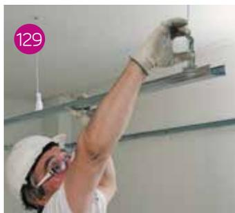
Pendini "a molla" applicati e in attesa dell'aggancio dei profili primari (fig. 128). Aggancio di un profilo primario e regolazione provvisoria di quota tramite schiacciamento della molla (fig. 129).
