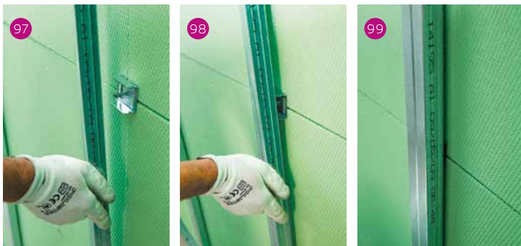
Sequenza di aggancio del profilo all'attacco distanziatore: avvicinamento (fig. 97), aggancio di un'ala del profilo all'intaccatura dell'attacco (fig. 98), rotazione e pressione per favorire l'incastro (fig. 99).
