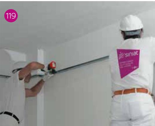
Taglio e fissaggio di spezzoni di guida perimetrali per contorno pilastro (fig. 117 - 118). Prosecuzione fissaggio guida (fig. 119).
