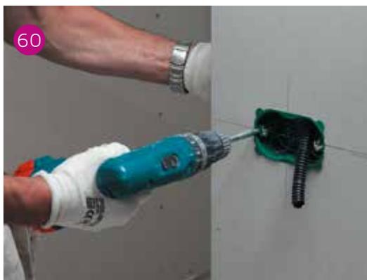
Fissaggio delle viti della scatola che viene così bloccata alle lastre.
