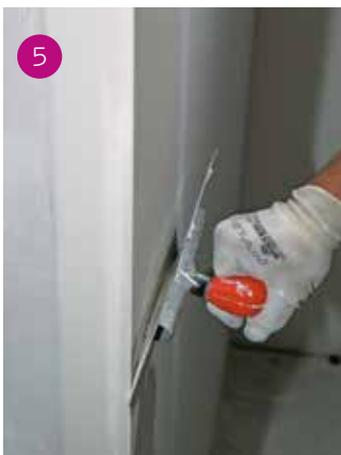
Rasatura dopo asciugatura della mano di riempimento.
