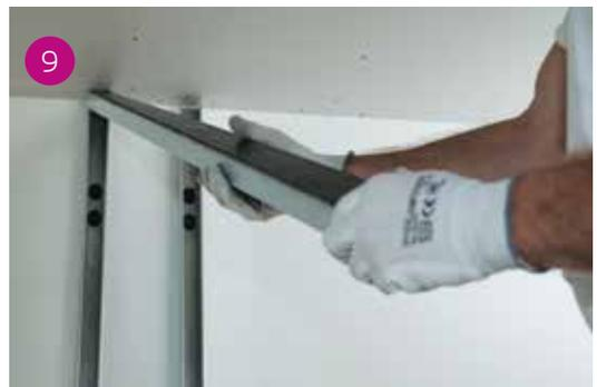
9 L'applicazione delle guide a soffitto avviene inserendole sulla testa dei montanti terminali.
