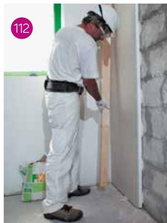
2° battitura con regolo, in alluminio o in legno, e contestuale allineamento alle tracce a pavimento e soffitto (fig. 112). Il posizionamento dei pannelli contigui avviene con la stessa procedura di cui alle immagini precedenti curando la complanarità dei pannelli fra loro.
