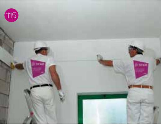
Definizione della quota a cui impostare le guide perimetrali della struttura secondaria tenendo conto dello spessore della lastra e della quota finita del controsoffitto (fig. 113 - 114). Tracciamento della quota con filo tracciante (fig. 115).
