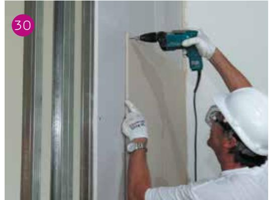
Posa del 2° paramento con l'applicazione di lastra intera a tutta larghezza per l'esigenza di sfalsamento dei giunti fra il primo e il secondo paramento (fig. 29 - 30).
