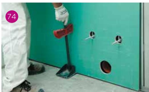
Esecuzione dei fori con fresa a tazza o seghetto e posizionamento della lastra in corrispondenza dei perni e del gomito di scarico.
