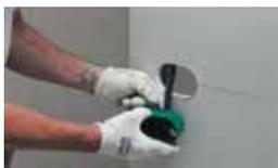
Taglio dei due fori circolari con l'impiego della fresa a tazza inserita sull'avvitatore, rettifica del foro e inserimento del corrugato nella scatola elettrica.
