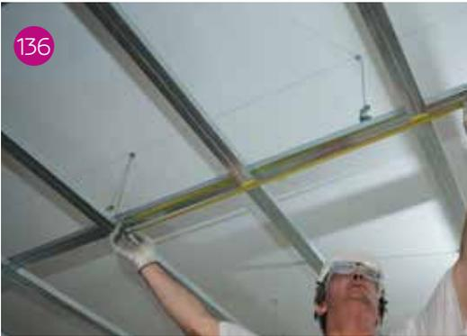
Controllo dell'interasse dei profili secondari per procedere agli assestamenti prima del loro bloccaggio con i pendini d'unione (fig. 136).
