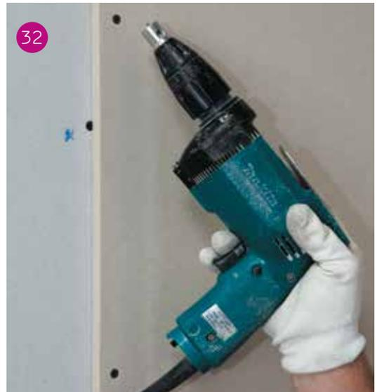
Nelle tre immagini (fig. 29 - 30 - 31), per la posa del 2° paramento si è simulata la situazione di giunto orizzontale fra lastre in caso di pareti a grande altezza. Il passo delle viti per l'avvitatura delle lastre di 2° paramento sarà di massimo  $25 \div 30$  cm. Un metodo pratico di avvitatura a passo corretto è quello di procedere controllando la distanza fra la base di impugnatura e la punta dell'avvitatore (fig. 32).
