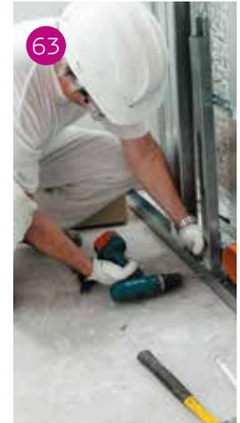
63 Fissaggio provvisorio del supporto e bloccaggio del gomito con il collare.
