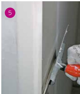
5 Rasatura dopo asciugatura della mano di serraggio, pressandola sullo spigolo.
