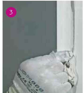
3 Piegatura e applicazione della banda armata, con le bande metalliche verso l'interno, pressandola sullo spigolo.
