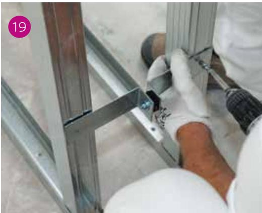
19 Fissaggio del connettore PHONI SL tramite avvitatura sul dorso dei montanti: minimo 2 viti per parte lungo i 45°.
