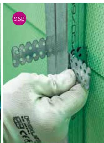
Fissaggio della guida perimetrale al piede (fig. 94) con eventuale posizionamento di foglio in plastica se presente acqua di risalita da pavimento (fig. 95). Si inseriscono quindi i profili le cui ali vengono avvitate sulle due lame delle staffe regolabili (fig. 96A) poi ripiegate, o ritagliate, per non creare ingombro all'avvitatura delle lastre (fig. 96B).
