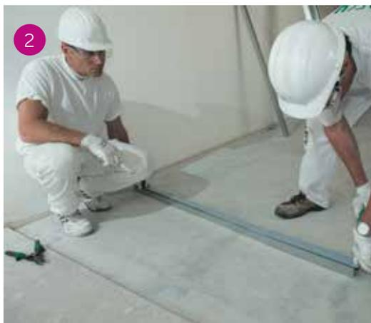
Applicazione della banda resiliente adesiva sul dorso della guida a pavimento.
