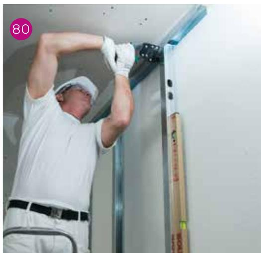
Fissaggio dei montanti tramite punzonamento.
