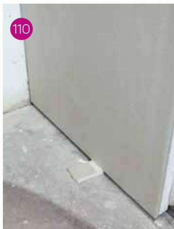
Spezzone di lastra al piede per l'isolamento dal contatto con il suolo (protezione dall'acqua di lavaggio pavimento).
