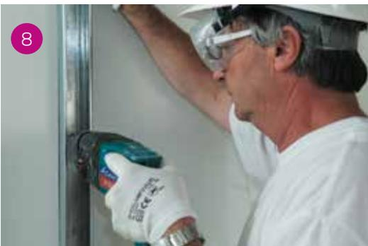
8 Avvitatura del montante ogni 40/50 cm con viti ad andamento a zig-zag. Si rammenta che, in caso di richiesta di prestazione acustica, la banda resiliente dovrà essere applicata sul dorso delle guide a pavimento e a soffitto e su quello dei montanti terminali per desolidarizzare la parete dalle strutture limitrofe (solai, pareti, travi e/o pilastri).
