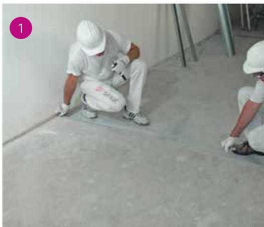
Tracciamento con filo tracciante per la realizzazione di una parete di tipo S.
