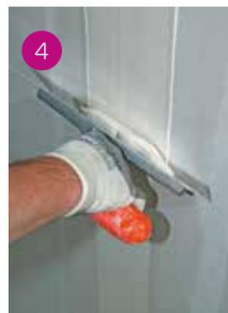
Rasatura a perfetta asciugatura della mano di riempimento.
