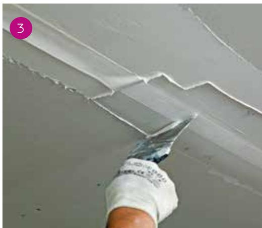
3 Serraggio della banda con rimozione delle sbavature.
