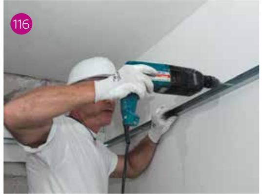
Fissaggio della guida perimetrale con viti a passo 50 cm.
