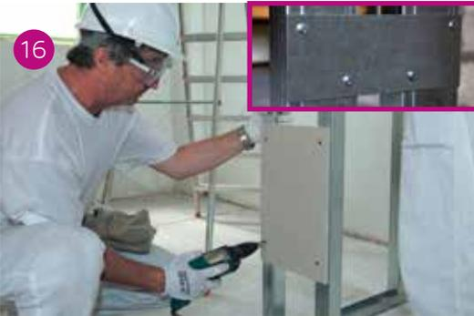
16 Applicazione delle lastre in cartongesso con la prima alla distanza di 30 cm da terra e le altre a 1,20 m d'interasse tra di loro. Nel riquadro viene illustrata l'applicazione delle bande in lamiera.
