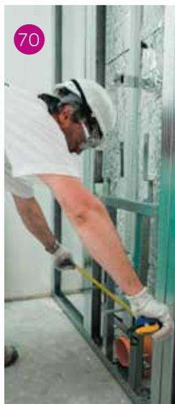
Inserimento delle barre di sospensione del WC e loro fissaggio a livello. Nell'immagine centrale il supporto installato con le forcelle per l'inserimento della cassetta di scarico.
