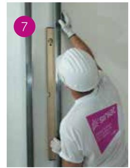
6 La parete può essere tracciata con il laser o con il pratico sistema utilizzato: si posizionano i montanti a ridosso della parete di partenza e si fissano verticalmente con il controllo della livella magnetica.
