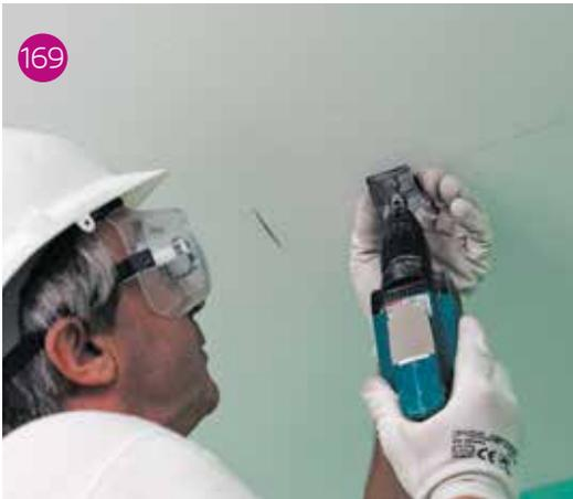
Fissaggio dell'attacco. La vite centrale ne permette la registrazione a livello.
