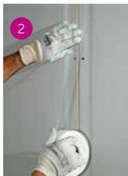
Applicazione della banda in rete adesiva è il sistema più rapido di armatura del giunto.
