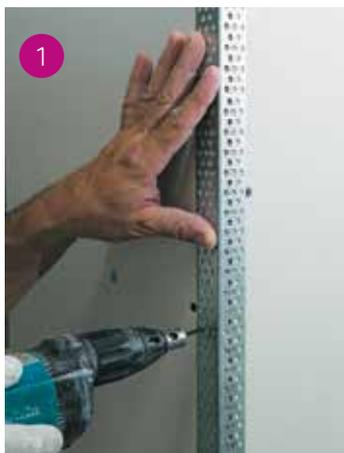
Fissaggio del paraspigolo tramite avvitatura.
