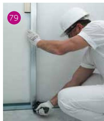
Posizionamento delle guide della controparete a pavimento e a soffitto e posizionamento dei montanti verticali.
