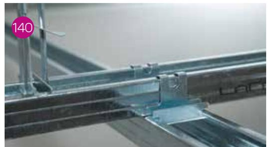
Procedimento di applicazione di pendini d'unione: inserimento delle dentature del pendino sui risvolti delle ali del profilo secondario (fig. 137- 138), piegatura della bandina metallica con serraggio contro l'ala del profilo primario (fig. 139). Applicazione ultimata sulle due ali del primario (fig. 140).
