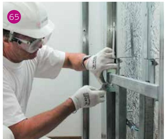
65 Applicazione delle piastre della traversa di controventatura del supporto e loro bloccaggio ai montanti.
