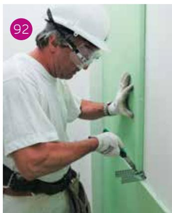
Per posizionare i pannelli superiori si procede al taglio, con seghetto, del pannello superiore per il suo assestamento nelle lame della staffa regolabile (fig. 92 - 93).
