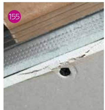
Posizionamento della seconda fila di lastre in posizione sfalsata rispetto a quella adiacente.
