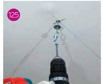
Inserimento nel foro del tassello ad ancora per aggancio alle pignatte di solai in latero cemento (fig. 123). Serraggio della vite a occhiello tramite una punta a gancio applicata all'avvitatore (fig. 124 - 125).
